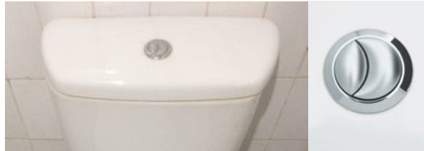
Gambar 6. Sistem dual bilas. Tombol kecil di sebelah kiri untuk fungsi membilas toilet ketika selesai buang air kecil. Tombol besar di sebelah kanan untuk membilas toilet ketika selesai buang air besar.
