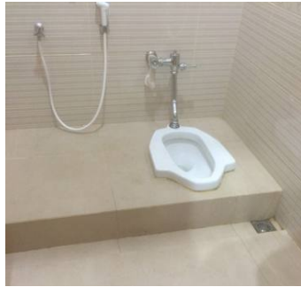
Gambar 5. Toilet jongkok salah satu fakultas yang dilengkapi dengan pembilas tubuh dan pembilas toilet otomatis.
