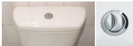
Gambar 7. Sistem dual bilas. Tombol kecil di sebelah kiri untuk fungsi membilas toilet ketika selesai buang air kecil. Tombol besar di sebelah kanan untuk membilas toilet ketika selesai buang air besar.
