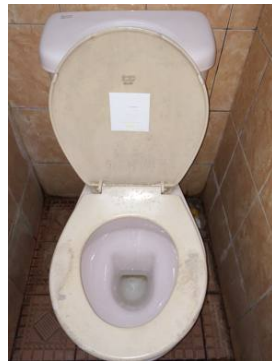
Gambar 6. Bekas kaki pada dudukan toilet.
