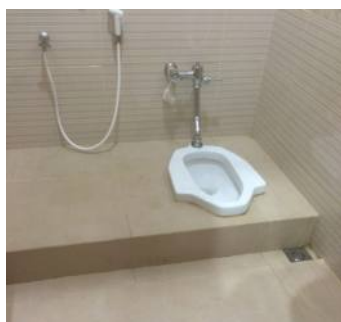
Gambar 5. Toilet jongkok salah satu fakultas yang dilengkapi dengan pembilas tubuh dan pembilas toilet otomatis.
