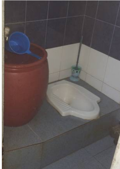
Gambar 4. Toilet jongkok menggunakan pembilas air yang ditimba dari kontainer air di samping toilet.
