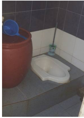
Gambar 4. Toilet jongkok menggunakan pembilas air yang ditimba dari container air di samping toilet.
